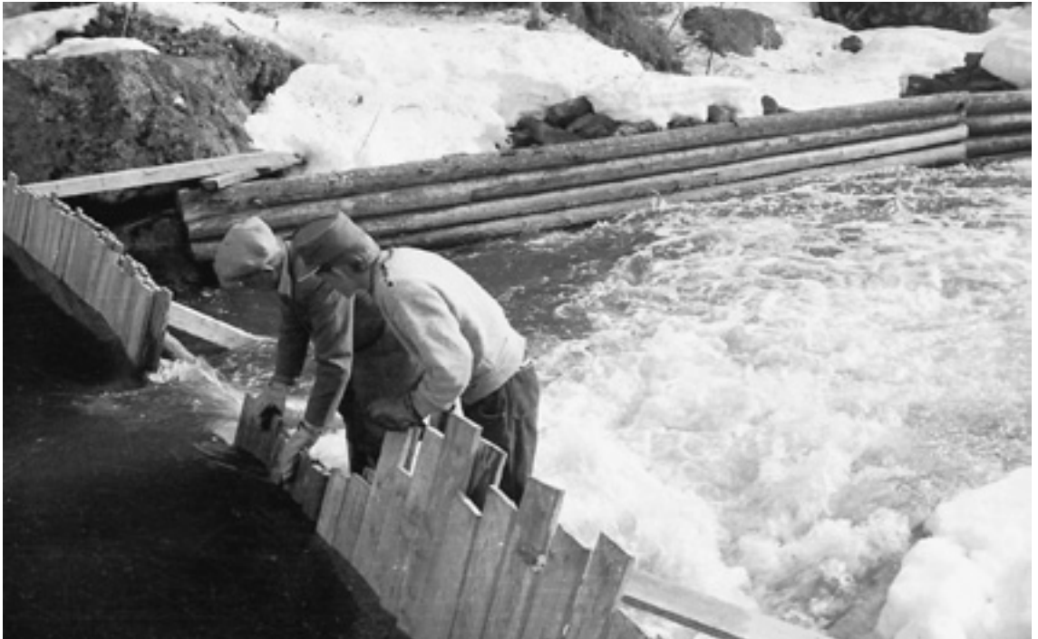
Eino ja Esa Mikkola korjaustöissä Tirvalla. Kuva: Esa Mikkola.
